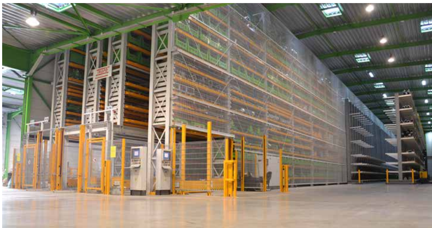
Automatyczny magazyn o kubaturze 28.000 m 3
