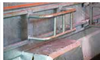
Zabezpieczenia z prętów
