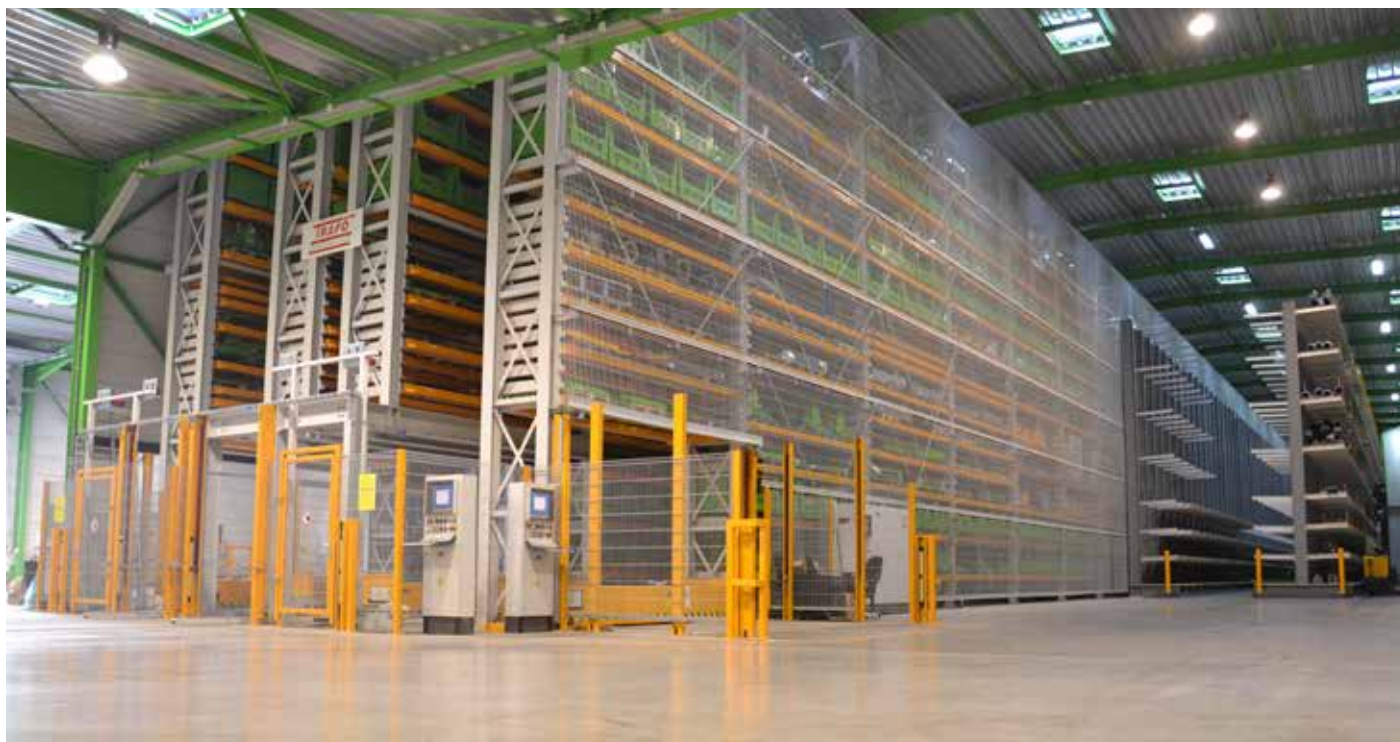
Automatyczny magazyn o kubaturze 28.000 m 3
