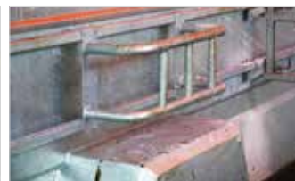
Zabezpieczenia z prętów
