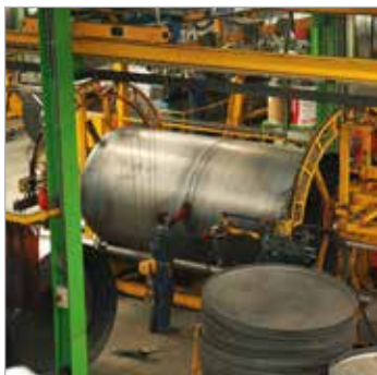
Łączenie segmentów i dennic zbiorników
