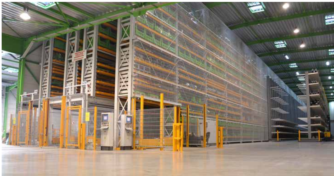
Automatyczny magazyn o kubaturze 28.000 m 3
