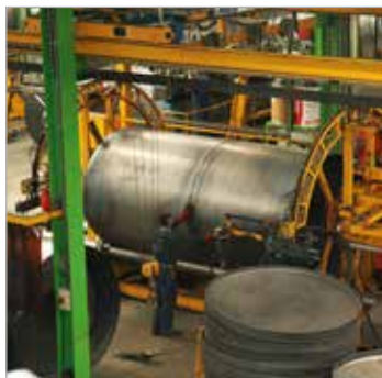
Łączenie segmentów i dennic zbiorników
