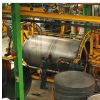
Łączenie segmentów i dennic zbiorników
