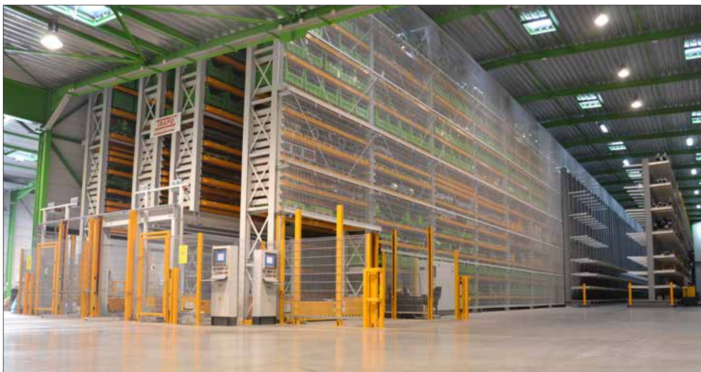
Automatyczny magazyn o kubaturze 28.000 m 3
