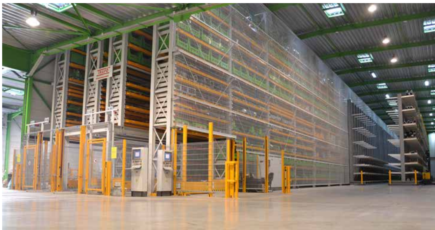
Automatyczny magazyn o kubaturze 28.000 m 3
