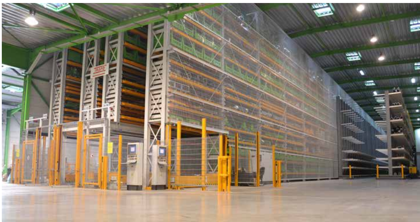
Automatyczny magazyn o kubaturze 28.000 m 3
