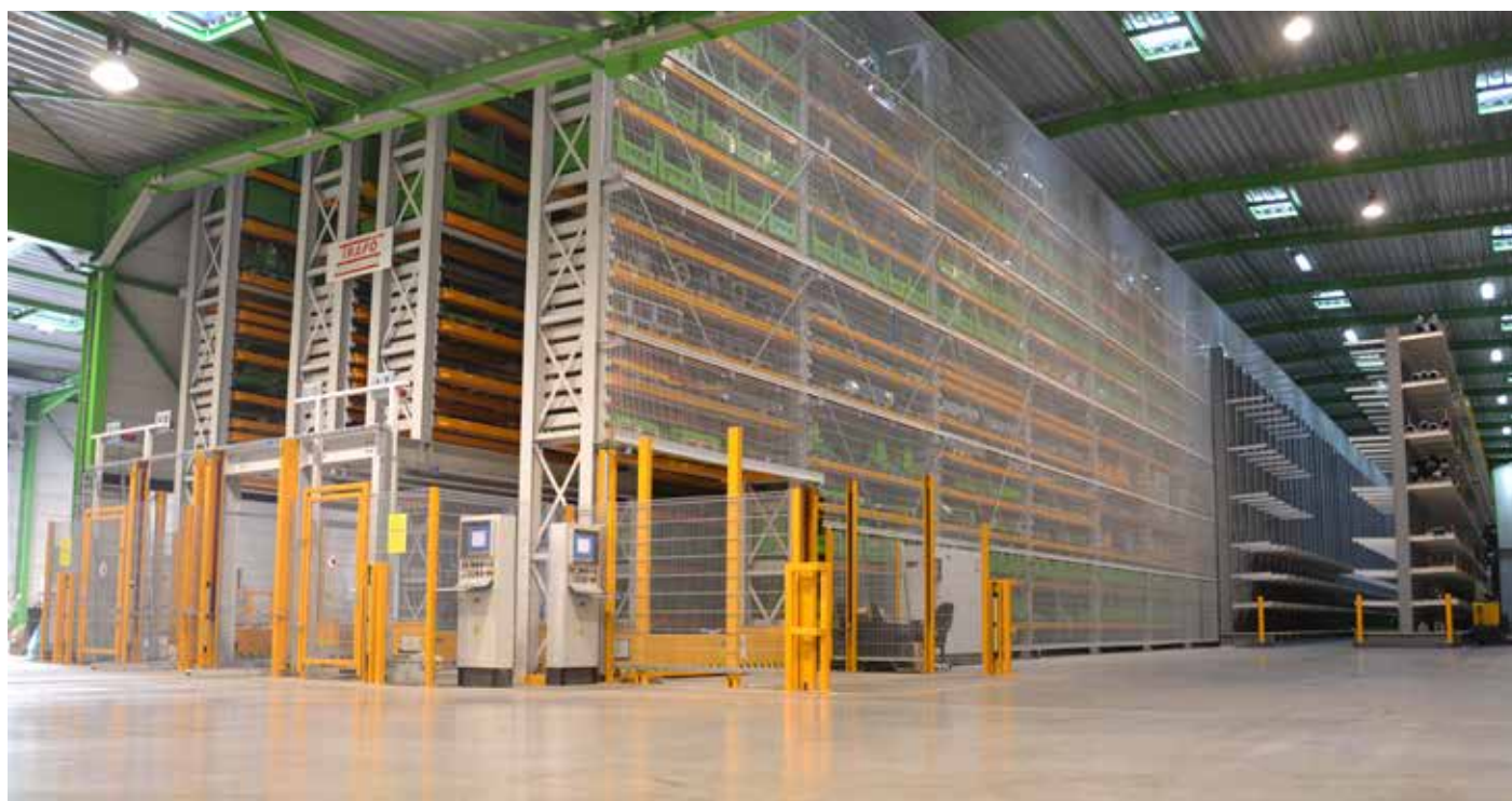
Automatyczny magazyn o kubaturze 28.000 m 3
