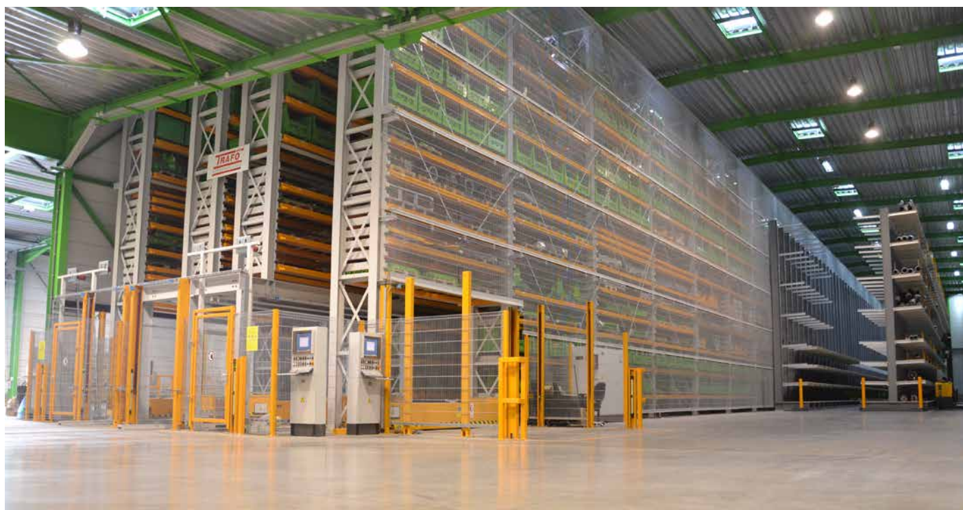
Automatyczny magazyn o kubaturze 28.000 m 3
