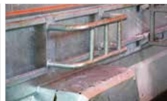
Zabezpieczenia z prętów
